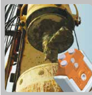
5 - Spezialtiefbau 旋挖钻机
