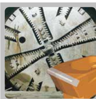
10 - Tunnelbau 隧道工程
