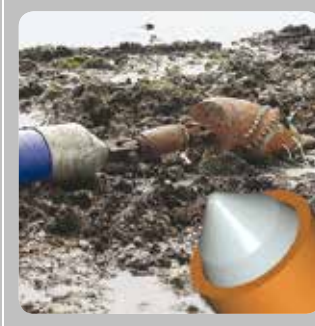
7 - Horizontales Bohren HDD 水平钻机
